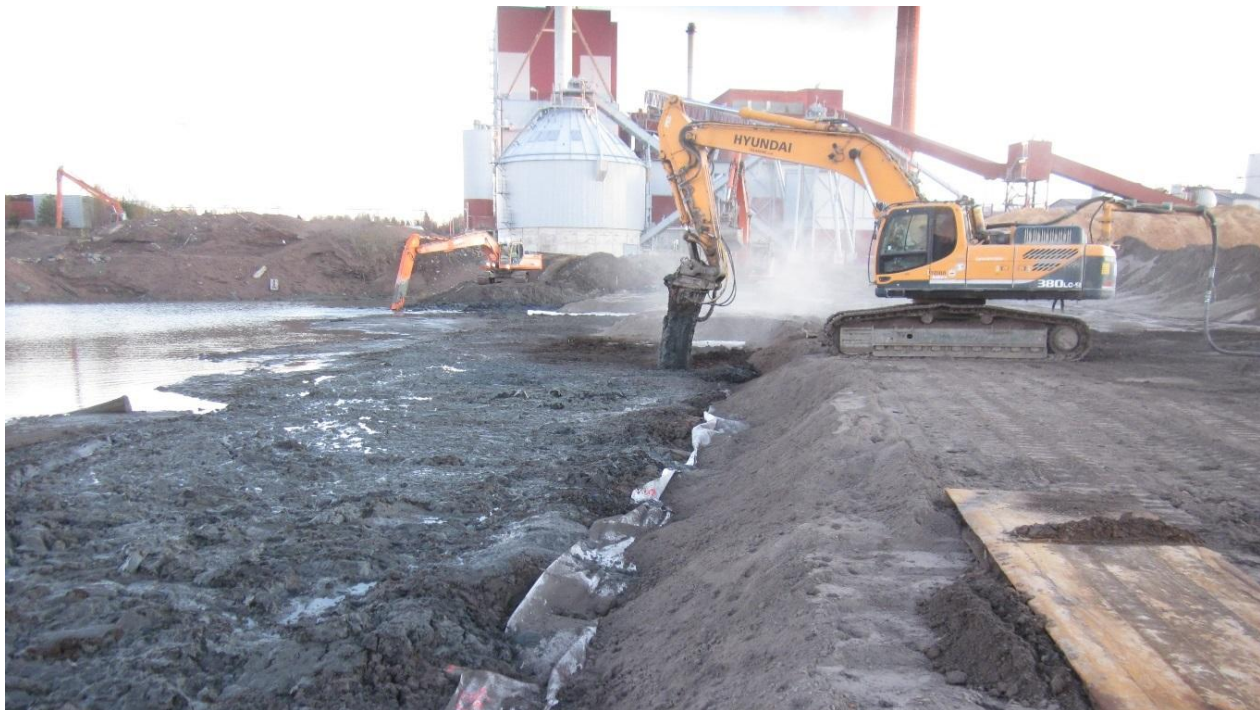
Kuva 5. Vuoden 2017 pilottialueen stabilointityö käynnissä. Taustalla pitkäpuomikaivinkone poistamassa haralla uppotukkeja altaasta.
