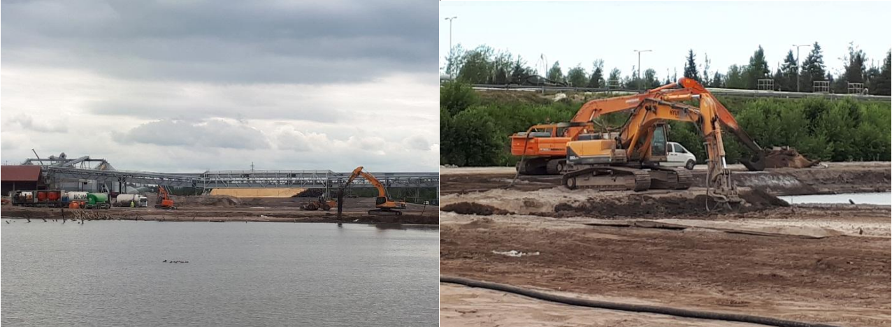
Kuvat 8 ja 9. Vuoden 2018 pilottialueen stabilointityö käynnissä.
